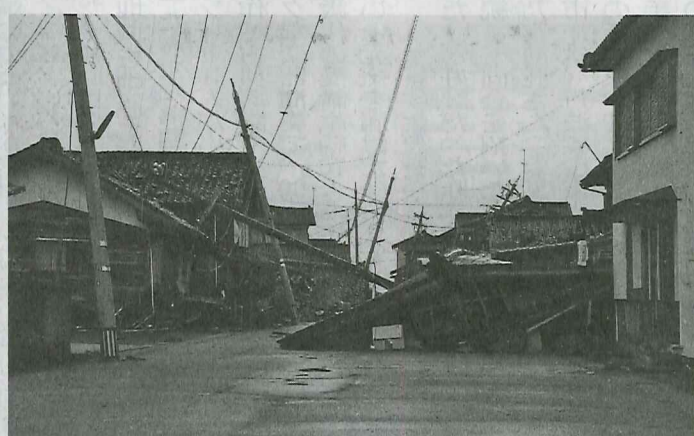
数多くの民家や電柱が倒れたままになっているまち=石川県珠洲市で
