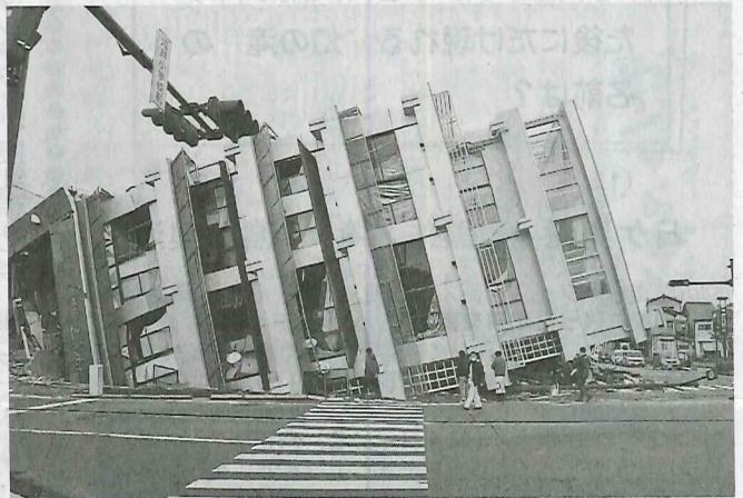
倒壊した7階建てのビル＝石川県輪島市で
